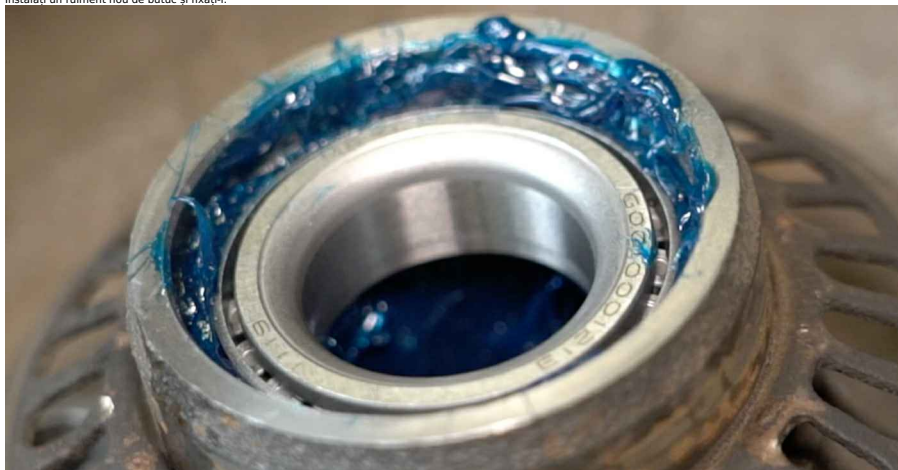
22 Montați garnitura de etansare cu ulei pentru rulmentul butucului roții.
