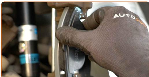
**23** Montați etrierul de frână și fixați-l.
